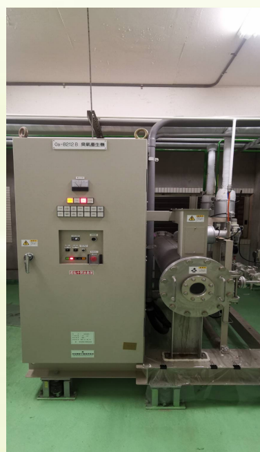
高級氧化系統 (AOP) (2 kg/hr O 3 )
